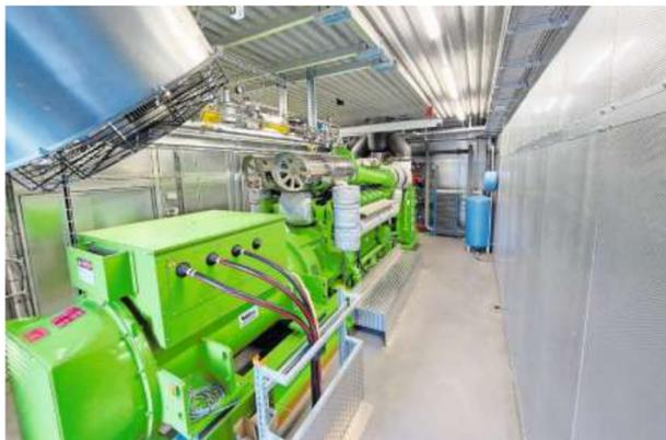
Wärme-Kraft-Koppelungsanlagen sind klein, effizient und dezentral – wie hier in einer Fernwärmezentrale in St. Gallen. Bild: Powerloop
